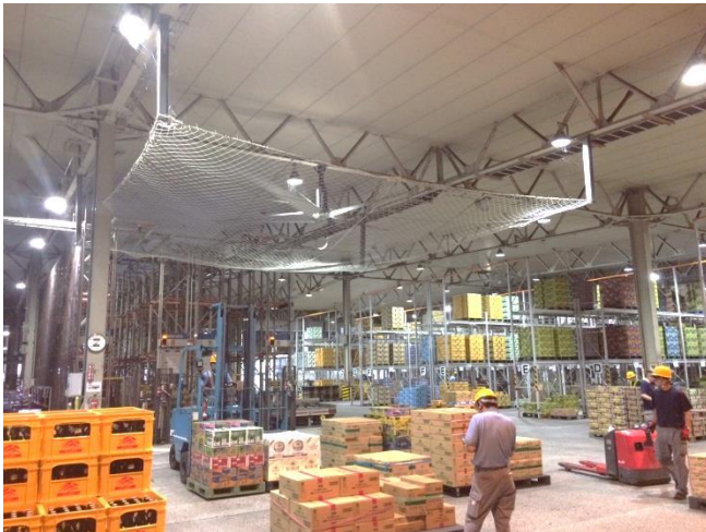
（大型ファン設置）
